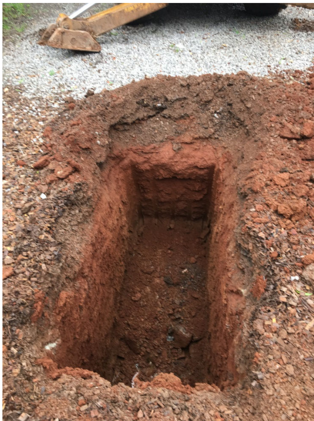
Furo para Inspeção do Solo junto local execução do pórtico
