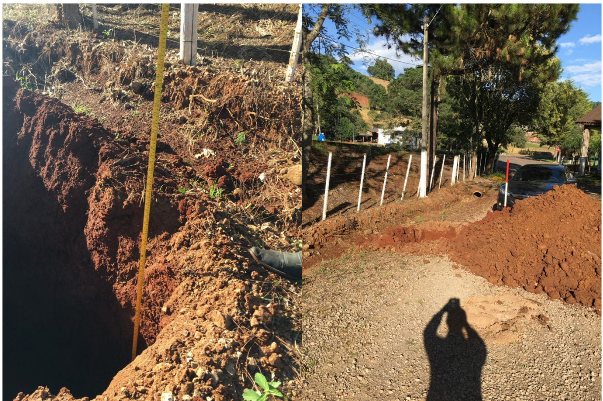
Furo 01 – distância local pórtico 20,00m – profundidade aproximada 1,50m
