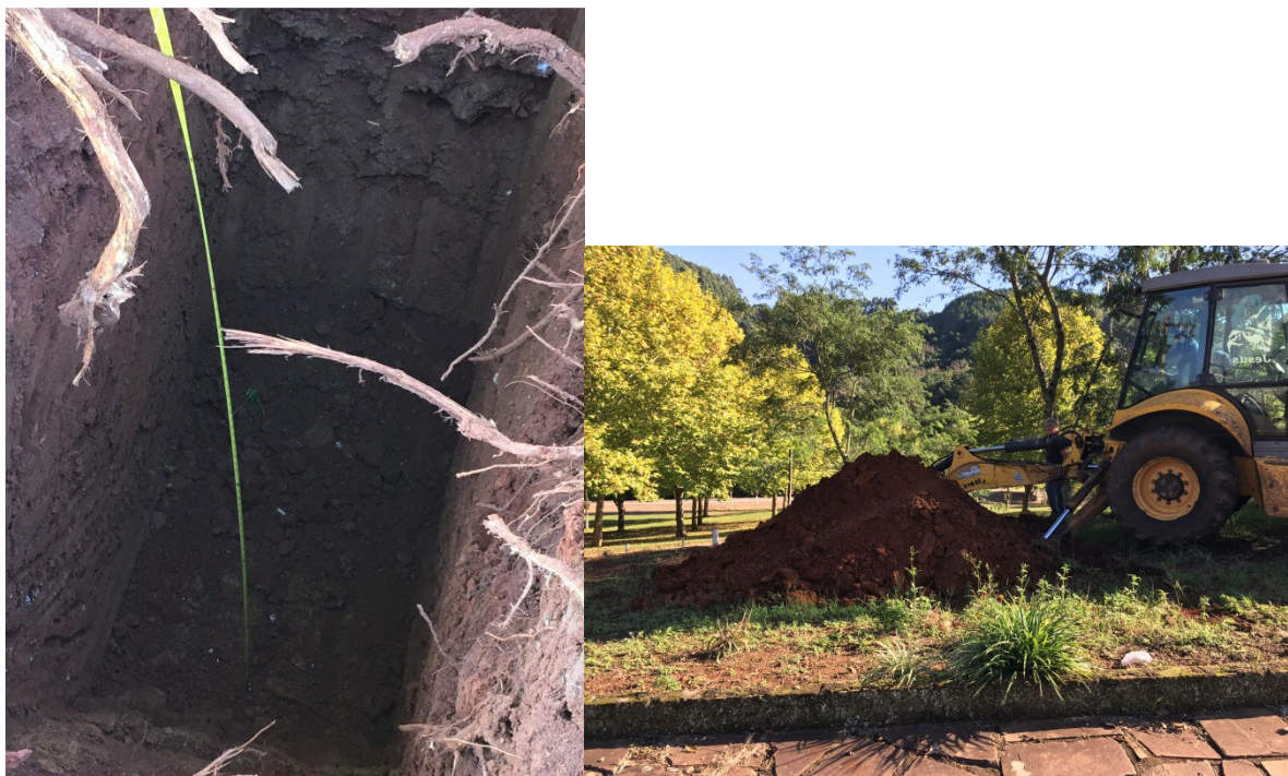
Furo 04 – distância local pórtico 130,00m – profundidade aproximada 2,20m
