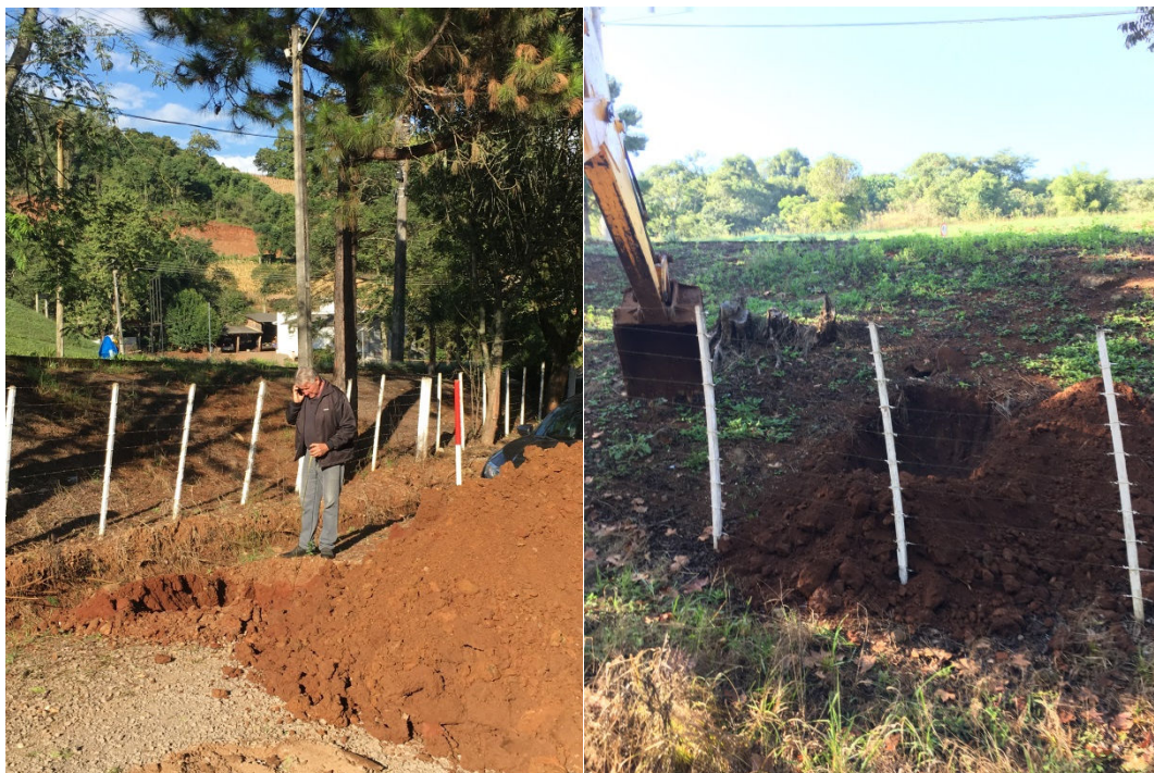
Furo 03 – distância local pórtico 90,00m – profundidade aproximada 0,40m
