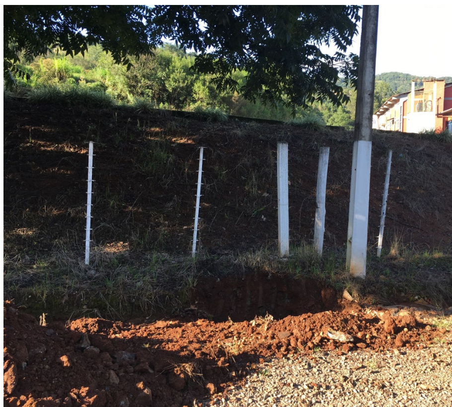
Furo 02 – distância local pórtico 55,00m – profundidade aproximada 0,30m
